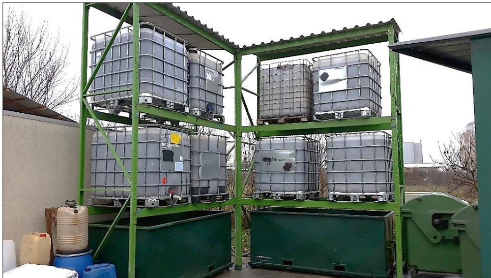
Fotografija A-6: Smještaj IBC spremnika sa otpadnom vodom na regalu iznad tankvane
