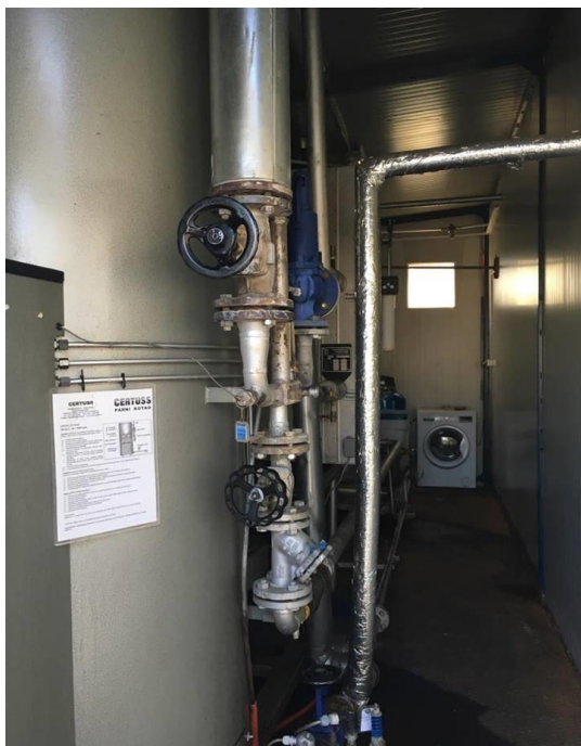
Fotografija A-3: Fotografija lijevo – postrojenje za redukciju i pripremu pare, fotografija desno – upravljačka i strojarska prostorija
